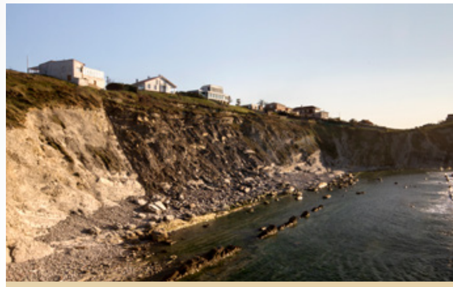
Retroceso de los acantilados en La Arnía
